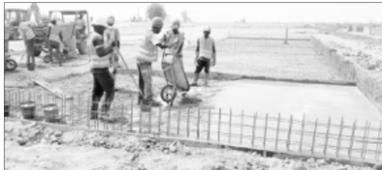
Chantier du centre hospitalier de Kaffrine.
